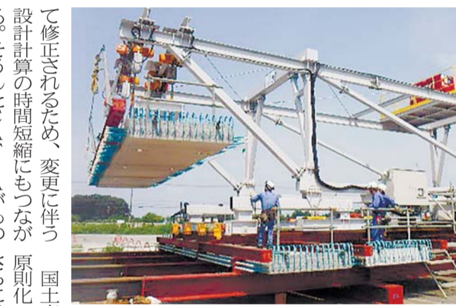
施工段階でのデータ活用も見据える
